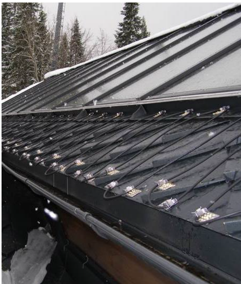
Край металлической кровли с подвесным жёлобом.
